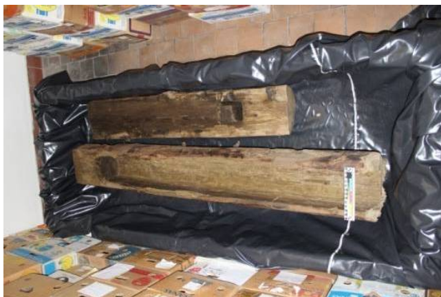
A064/2014 Žďár nad Sázavou, čištění a dezinfekce vodovodu
