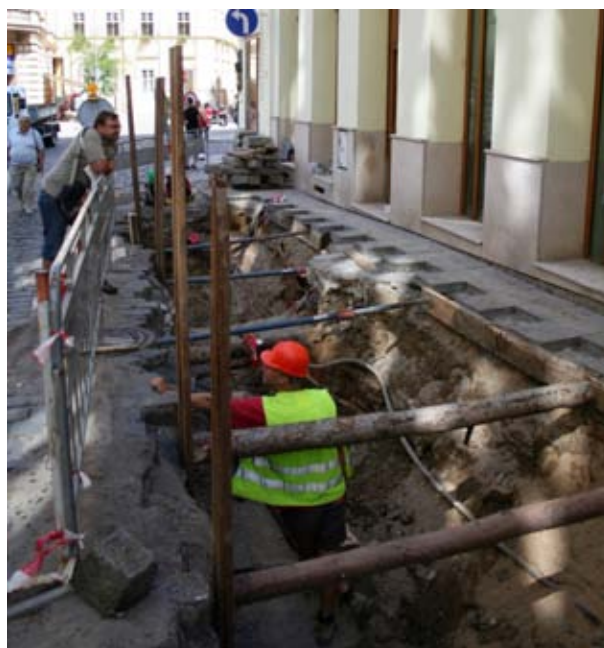
Trasa výkopu na Dominikánské.
