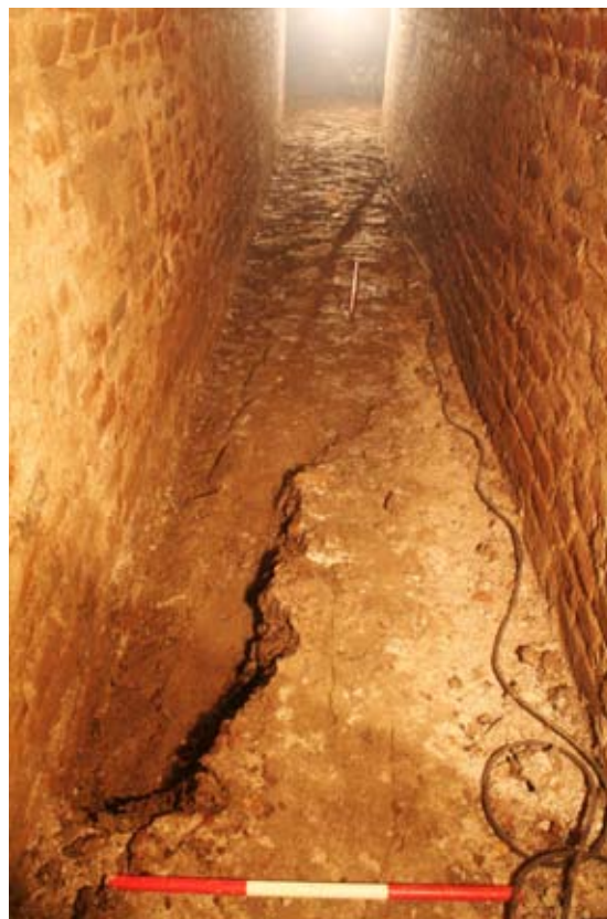
Chodba bastionu IV, pod podlahou chodby byl zachycen povrch starší komunikace.
