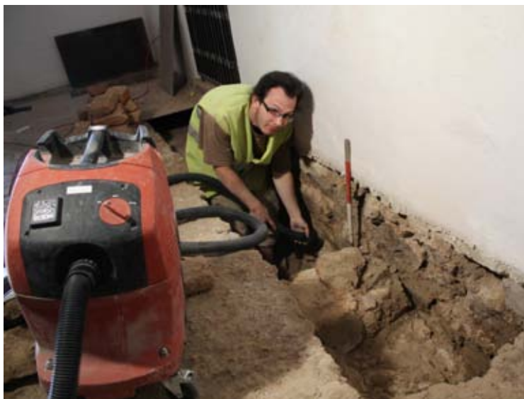
Stará radnice, Pavel Staněk začištuje odkryté konstrukce.
