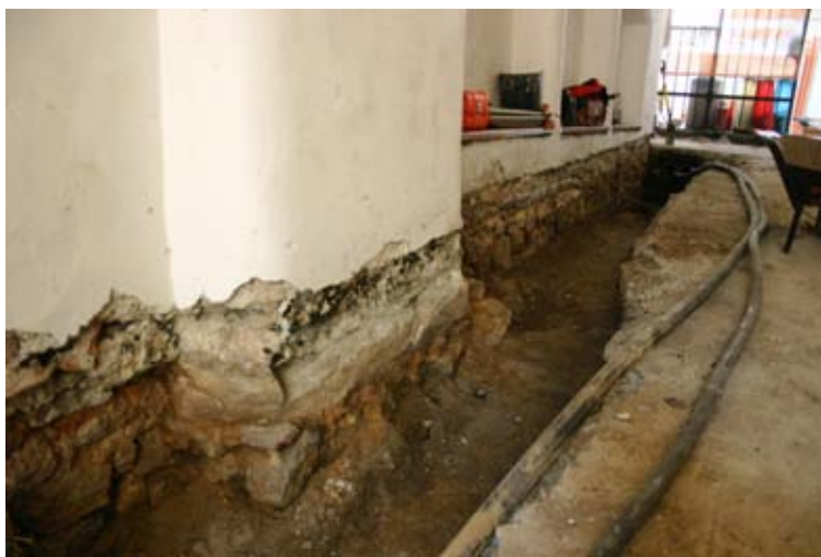
Stará radnice, pohled na výkop v průjezdu radničního jádra.
