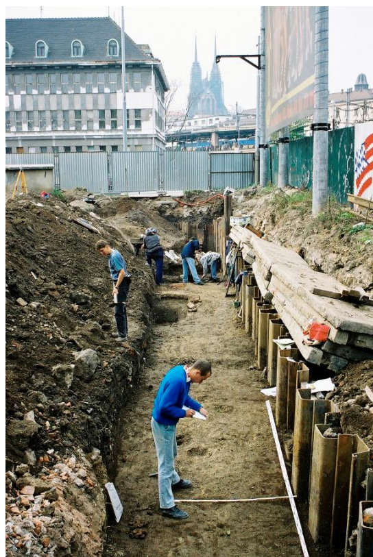
Výzkum při stavbě kolektoru na Spálené ulici v Brně
