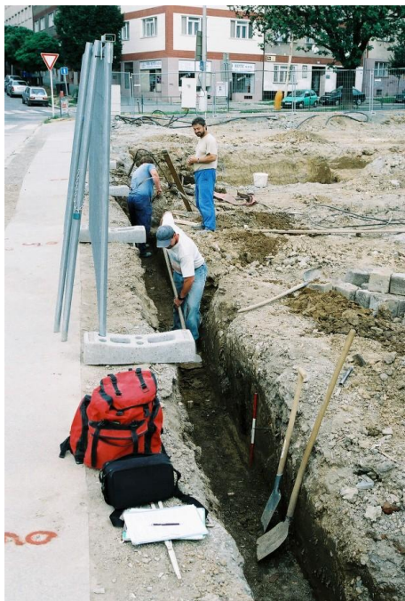
Dokumentovaný základový pas na Mojmírově náměstí v Králově poli v Brně
