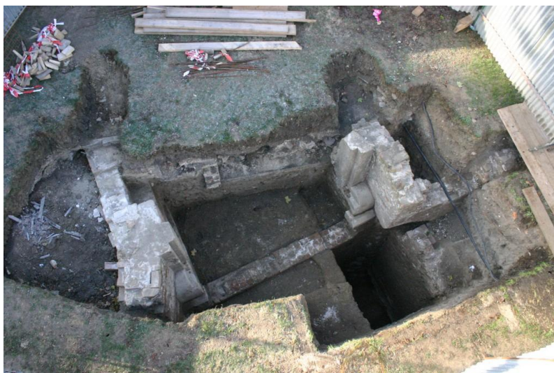
Základy Běhounské brány odkryté v rámci průzkumu bloku 51 na
