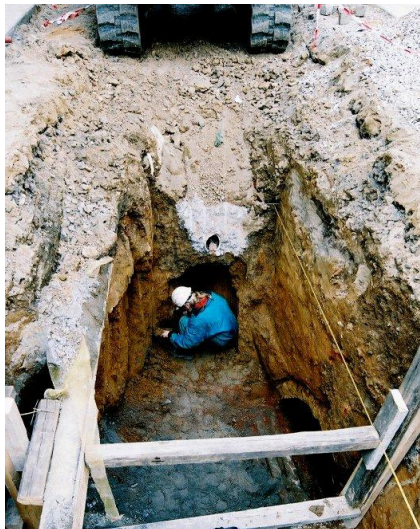
Jihlava, Smetanova - dokumentace výkopu kanalizace.
