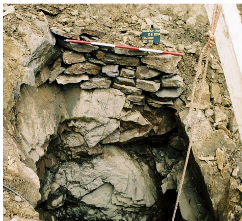
Rančířov - kamenné základové zdivo.
