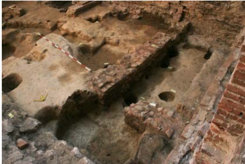
Dokopaná plocha ZAV probíhajícího v rámci rekonstrukce hotelu Padowetz.
