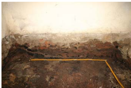
Dokumentace požárových souvrství ve sklepě.
