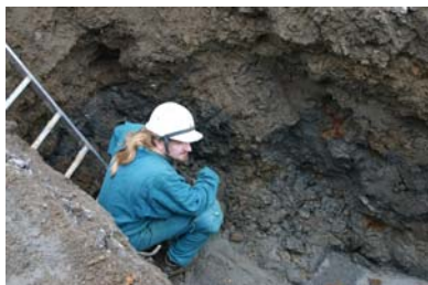
Mgr. P. Hrubý ve výkopu pro kanalizaci při odběru vzorků.
