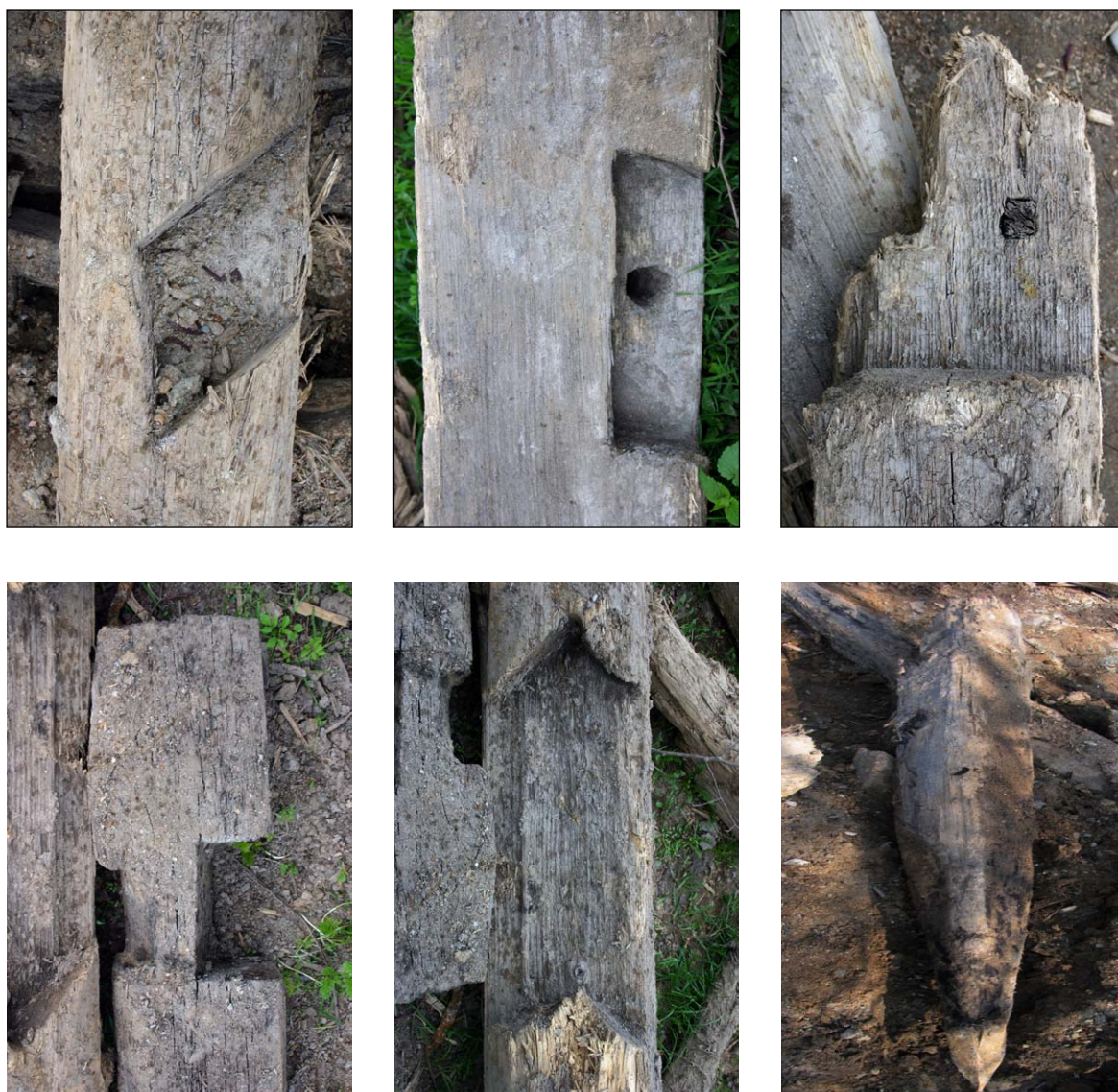
Obr. 10 Kapsy dlabaných spojů, pilot se železnou botkou
