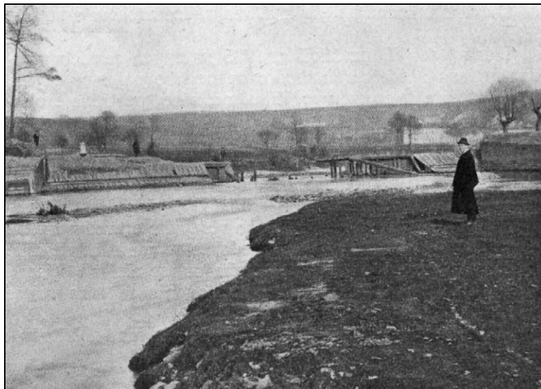
Obr. 1 „Strž cacovského jezu, způsobená dřenící ledů 28. 12. 1902“ (Frank 1936)
