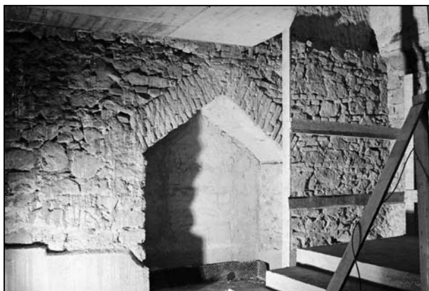
Obr. 2: Brno, Dominikánská 9, pohled ze severovýchodu na jižní zeď západního raně gotického suterénu s lomeným vstupem, vyzděným maloformátovými cihlami.
