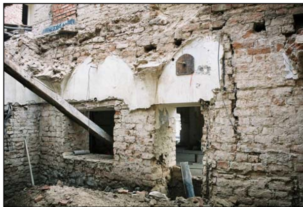
Obr. 16: Brno, Dominikánská 7, pozdně gotické cihlové zdivo přízemí.
