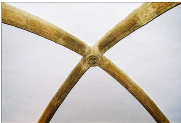
Obr. 9: Brno, Minoritská 2, křížová klenba v místnosti 3.02. přízemí jižního jádra.
