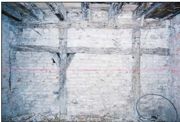
Obr. 12: Brno, Mečová 8, hrázděná severní zeď místnosti 2.01 přízemí.
