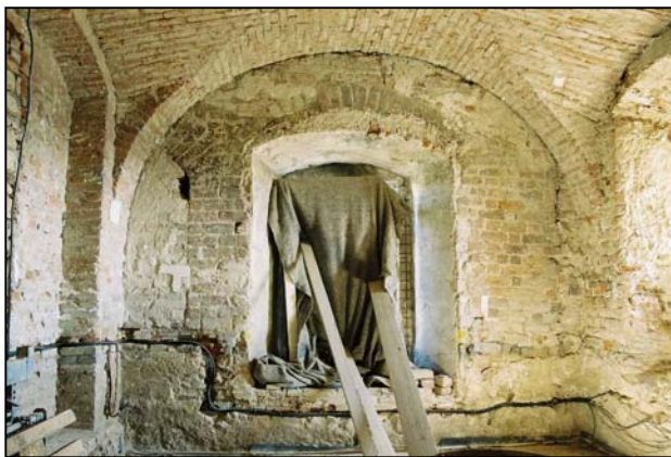
Obr. 15: Brno, Petrov 3, pohled ze západu na arkády a okno místnosti 1.01 někdejšího přízemí pozdně gotického domu.
