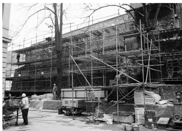
Obr. 62. Husova ulice (A003/2004). Celkový pohled na opravovaný úsek hradby od jihozápadu. Husova-Straße (A003/2004). Gesamtansicht des reparierten Abschnitts der Stadtmauer vom Südwesten.
