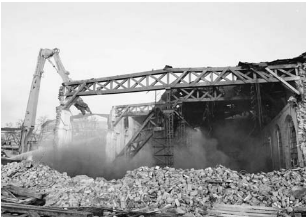
Obr. 58. Ulice Trnitá, areál továrny Vaňkovka (A114/2003). Demolice továrních budov. Trnitá-Straße. Fabrikareal Vaňkovka (A114/2003). Demolition der Fabrikgebäude.
