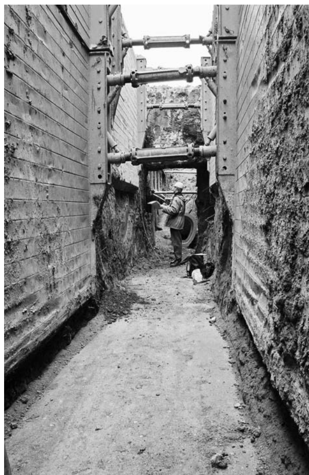
Obr. 15. Ulice Mozartova (A063/2002). Dokumentace archeologických situací ve výkopu kanalizace. Mozartova-Straße (A063/2002). Dokumentation archäologischer Befunde in dem Kanalisation-saushub.
