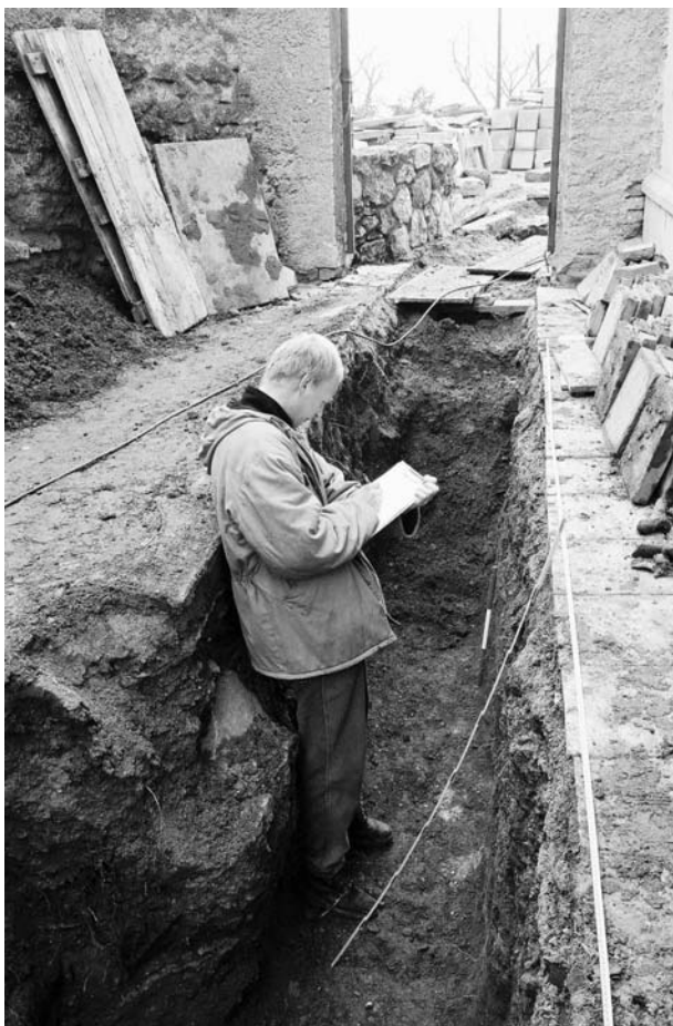
Obr. 21. Petrov (A082/2002). Dokumentace situací ve výkopu kanalizace. Petrov (A082/2002). Dokumentation der Befunde in dem Kanalisationsaushub.
