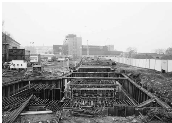
Obr. 52. Ulice Trnitá (A101/2003). Celkový pohled na výkop kolektoru. Trnitá-Straße (A101/2003). Gesamtansicht des Aushubs für den Kollektor.
