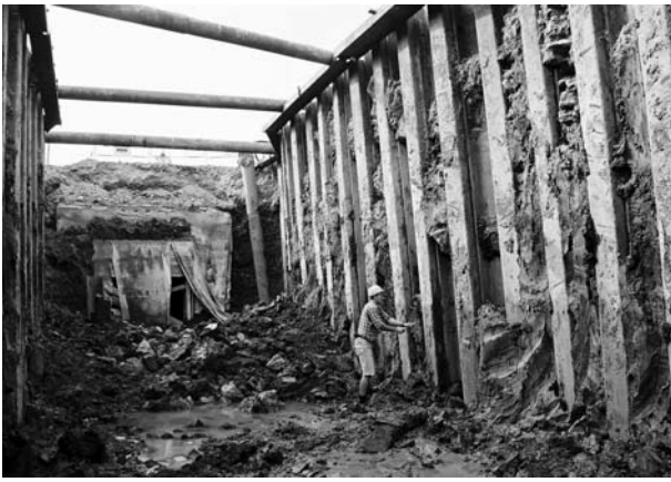
Obr. 3. Ulice Dornych (A006/2002). Začšřování reliktů archeologických a geologických situací ve stěně kolektoru.
