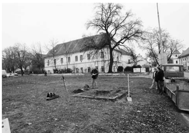
Obr. 61. Mojžírovo náměstí (A117/2003). Výkop pro betonový základ kříže. Mojžírovo náměstí (A117/2003). Aushub für das Betonfundament des Kreuzes.
