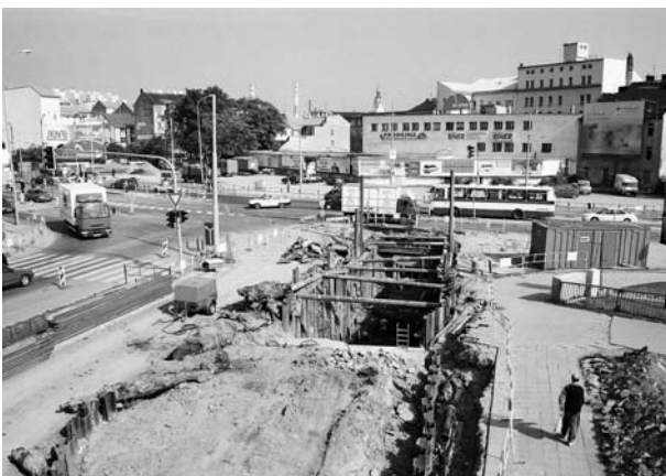
Obr. 4. Ulice Dornych (A006/2002). Celkový pohled na úsek kolektoru v křižovatce ulic Dornych a Úzká. Dornych-Straße (A006/2002). Gesamtansicht des Kollektorabschnitts auf der Straßenkreuzung Dornych-Úzká.
