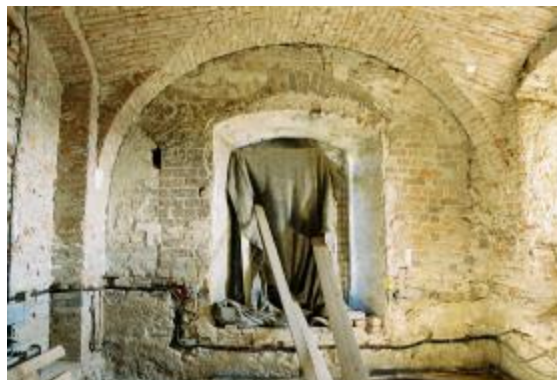
Obr. 20. Petrov 3 (A13/2001), pozdně středověká místnost v suterénu domu. Petrov 3 (A13/2001), Spätmittelalterlicher Raum im Unergesschoss des Hauses.
