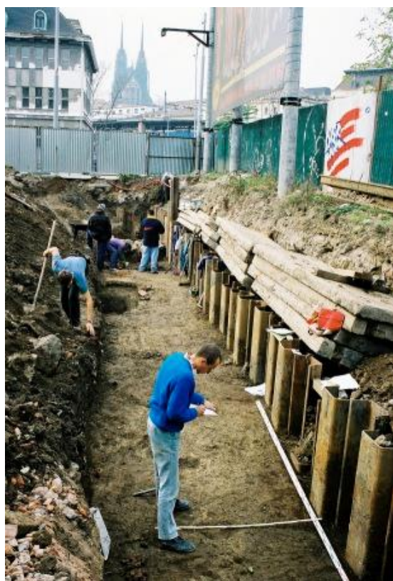
Obr. 38. Spálená (A174/2001) – výzkum kolektoru Spálená (A174/2001) – Ausgrabung im Kollektorgaben.
