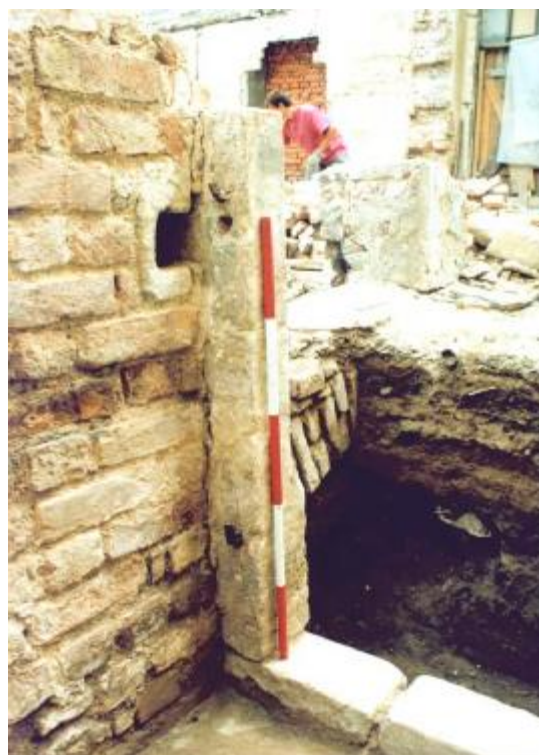
Obr. 21. Františkánská 9 (A224/2000), pohled od sz. na východní část gotického portálku s kapsou pro závory. Františkánská Str. 9 (A224/2000), Blick vom Nordwesten auf den östlichen Teil des gotischen Portals mit dem Türriegelloch.
