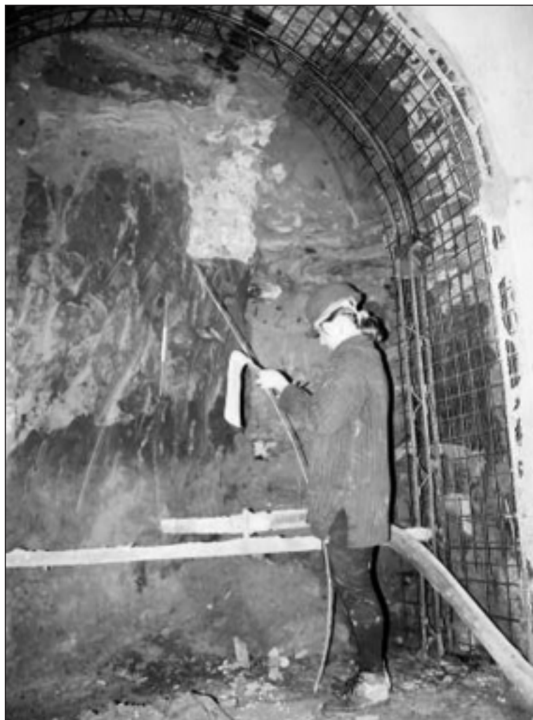
obr. 25 Koblišná, dokumentace řezu v průběhu ražby kolektoru v roce 2003 (archív Archaia Brno i.č. 211-03-06).
