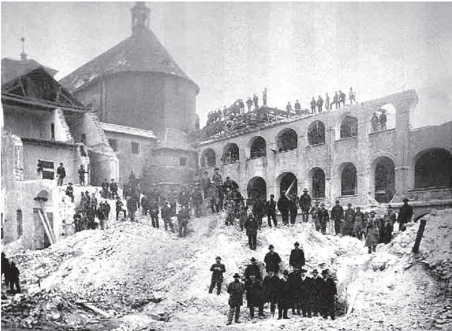
Příloha č. 7: Demolice V. dvora. Nedatováno.
