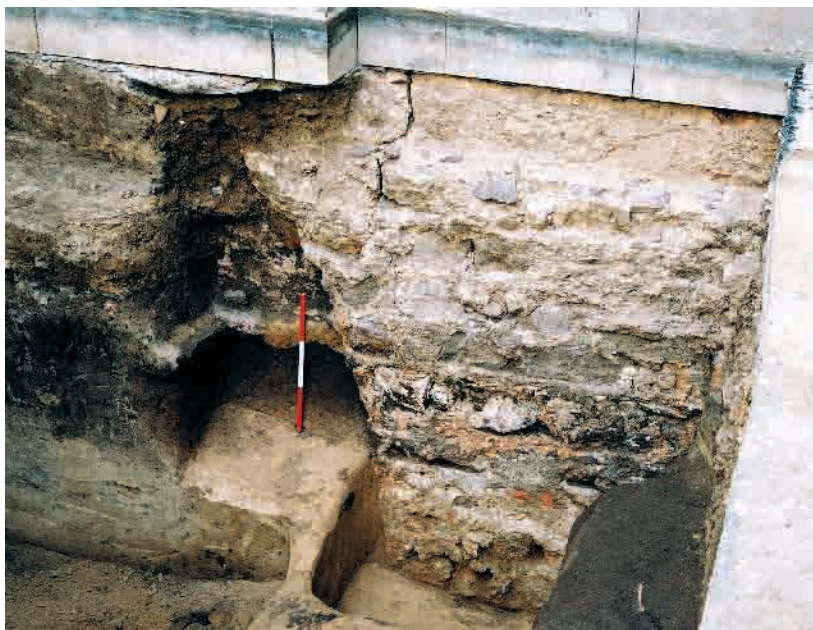
Barevná příloha č. XXVIII: Pohled na obnažené vrcholně středověké základové zdivo dnešní kaple sv. Františka Xaverského. Sonda A5, blok 39.
