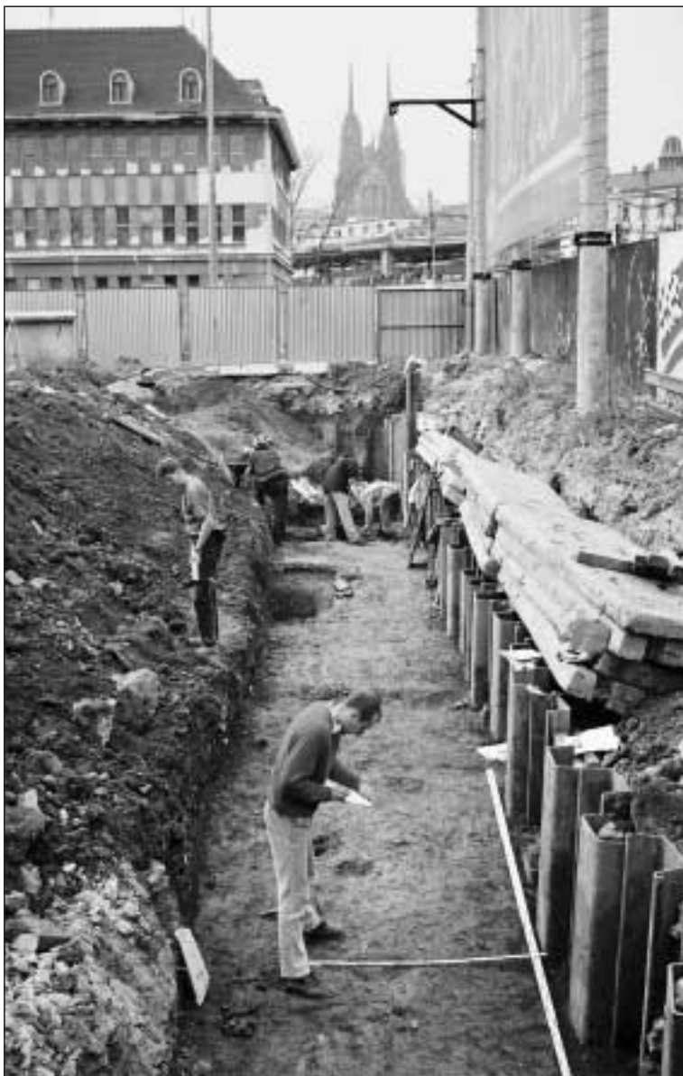
obr. 20 Antonín Zůbek při dokumentaci výkopu pro kolektor na Spálené ulici v roce 2002 (archiv Archaia Brno i.č. 116-01-13).
