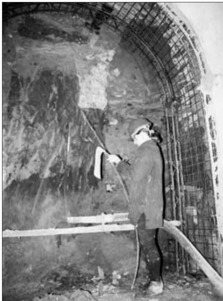
obr. 25 Kobližná, dokumentace řezu v průběhu ražby kolektoru v roce 2003 (archív Archaia Brno i.č. 211-03-06).
