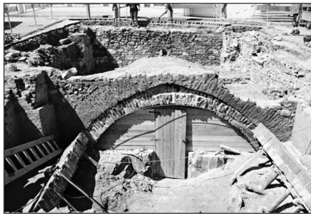
Obr. 11: Brno, Dominikánské náměstí 2 (dům cisterciáček ze Starého Brna), pas nosící příčku 1. nadzemního podlaží vyzděný z nízkých cihel formátu I.3.
