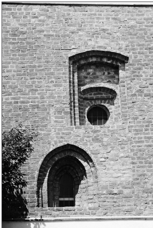
Obr. 17: Brno, Stará radnice – Radnická 8, vyzdění 2. nadzemního podlaží domu z vysokých cihel formátu II.2.
