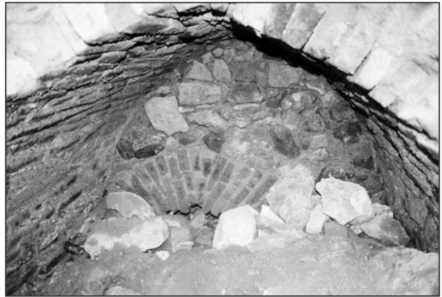
Obr. 13: Brno, Kapucínské náměstí – sklep s vyzděním klenby z nízkých gotických cihel formátu I.2.
