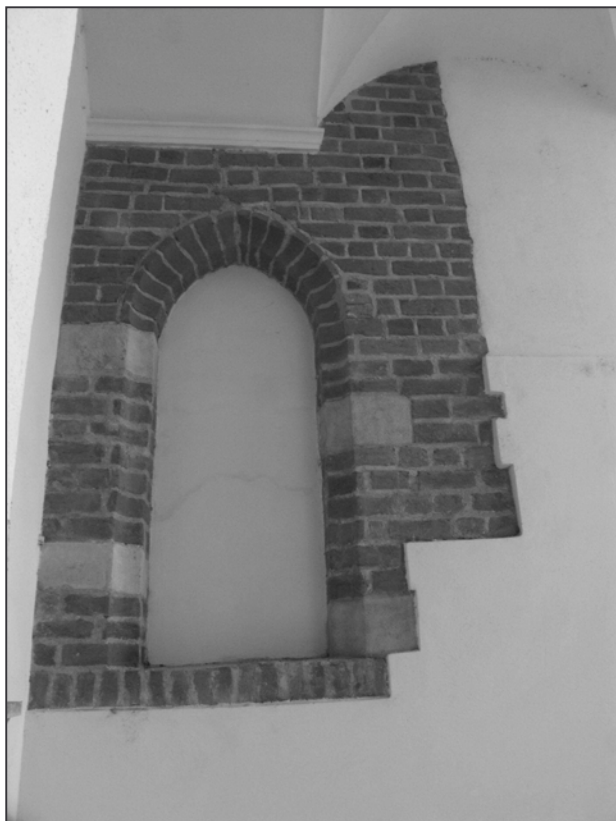
Obr. 20: Brno, Biskupský dvůr – Muzejní, Biskupský dvůr. Vyzdění okna ve 2. nadzemním podlaží z vysokých cihel formátu II.1.
