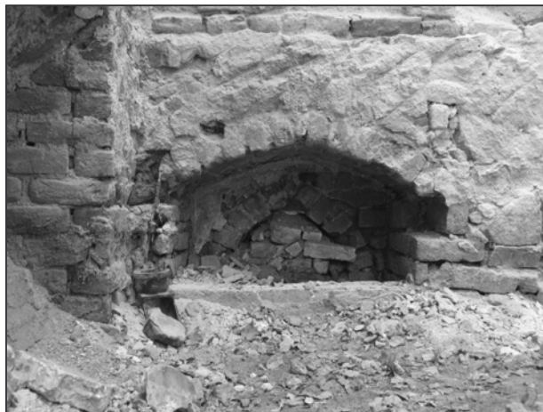
Obr. 7: Brno, klášter kartuziánů v Králově Poli. Vyzdění vstupu z chodby velkého ambitu do prostoru jedné z mnišských zahrádek z vysokých cihel kategorie II.2.
