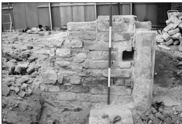
Obr. 19: Brno, Františkánská 9, cihelné obvodové zdivo 1. nadzemního podlaží domu z vysokých cihel kategorie II.2.
