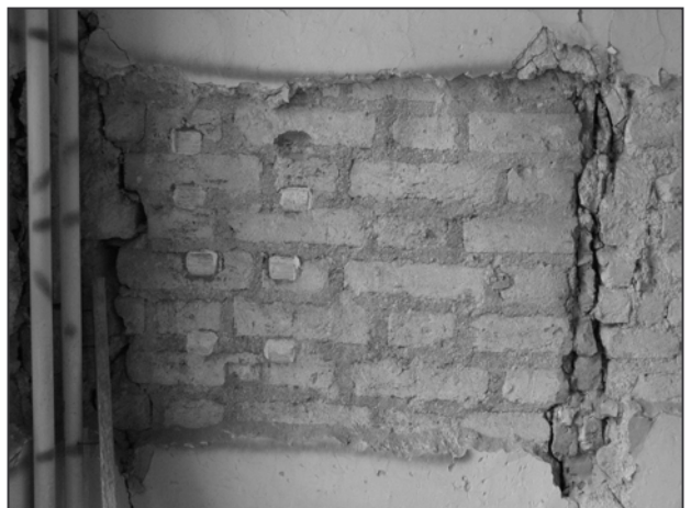
Obr. 26: Brno, Orlí 16, pozdněgotické obvodové zdivo 2. nadzemního podlaží z cihel kategorie II.1.
