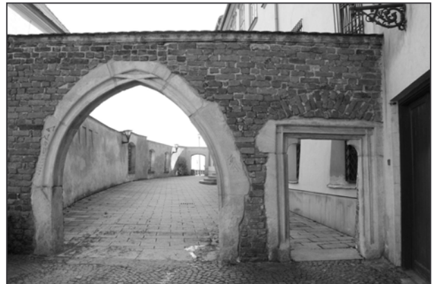
Obr. 25: Brno, Petrov 2, portál umístěný v pozdněgotické konstrukci z vysokých cihel formátu II.1.
