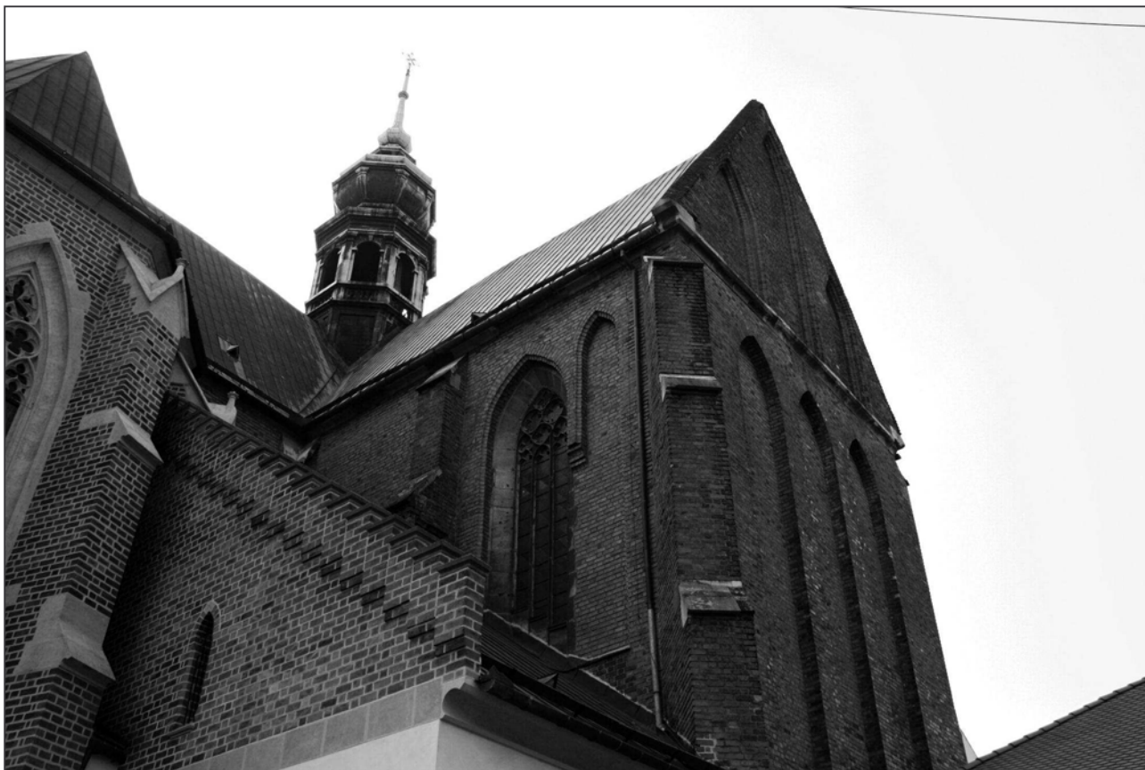
Obr. 4: Brno, klášter cisterciáček na Starém Brně. Cihelné zdivo chrámu Nanebevzetí Panny Marie.
