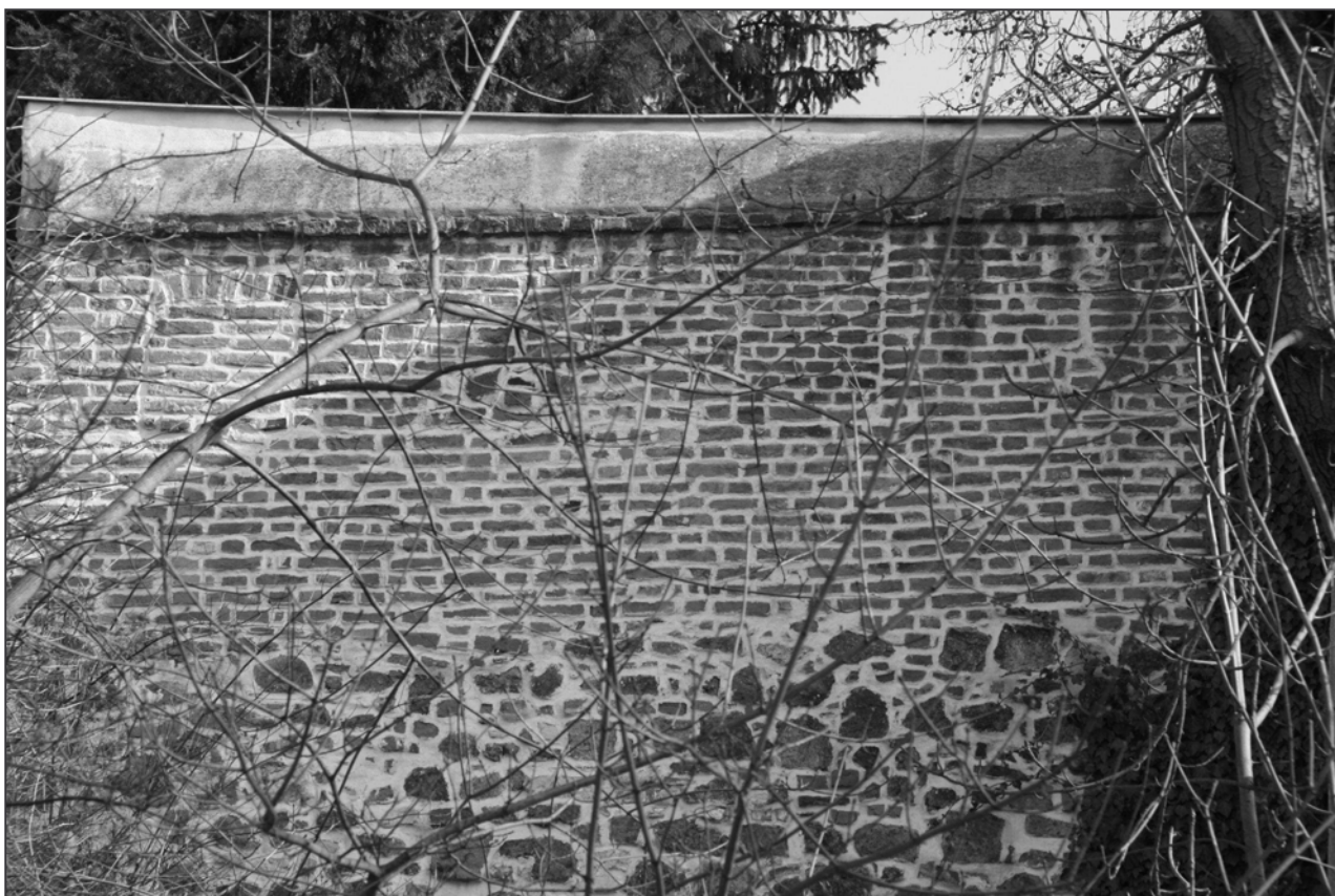
Obr. 27: Brno, Denisovy sady, vyzdění stínek městské hradby z nízkých cihel formátu I.2.
