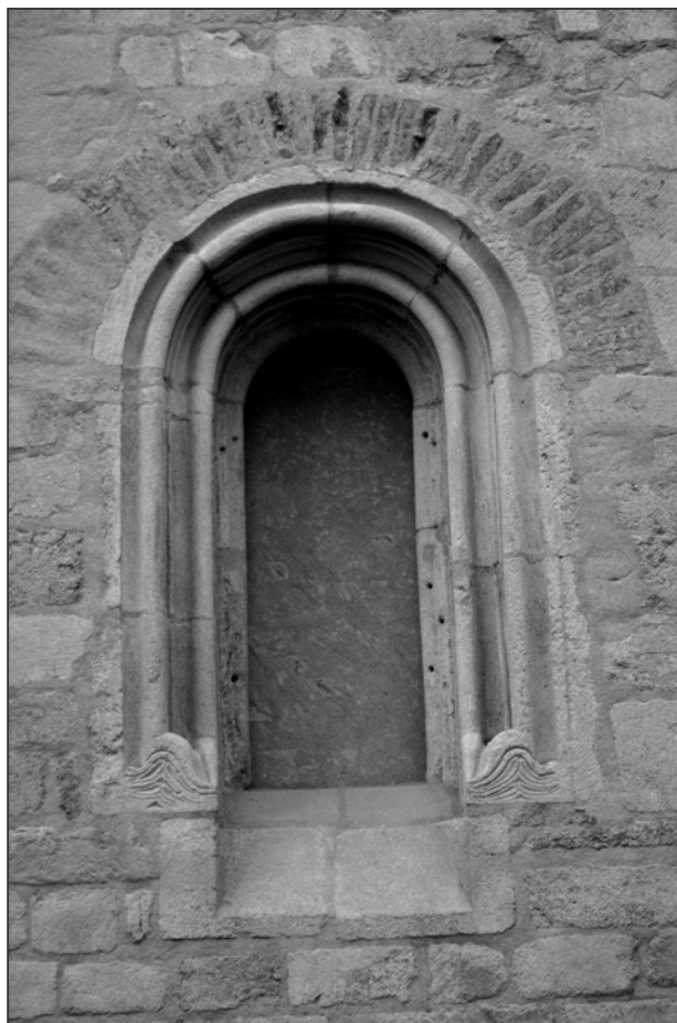
Obr. 1: Brno-Zábrdovice, kaple sv. Kunhuty. Segmentový pas nad oknem kaple z nízkých cihel kategorie I (všechny snímky fotoarchiv Archaia Brno o. p. s.).
