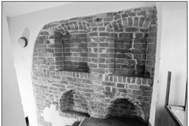
Obr. 18: Brno, Stará radnice, vyzdění 2. nadzemního podlaží domu z vysokých cihel formátu II.2.
