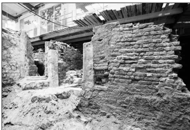
Obr. 10: Brno, Panská 6-8, obvodová zeď 1. podzemního podlaží z cihel formátu I.2.
