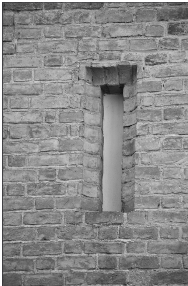
Obr. 21: Brno, Muzejní, Biskupský dvůr. Vyzdění okénka z vysokých cihel formátu II.1.
