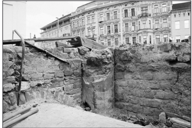
Obr. 24: Brno, Dominikánská 1-3, reliktu cihelných konstrukcí v 2. nadzemním podlaží.
