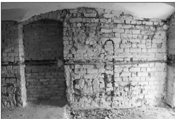
Obr. 16: Brno, Petrov 3, exteriérová strana zdiva z vysokých gotických cihel formátu II.2 s vyzděným štěrbinovým okénkem.
