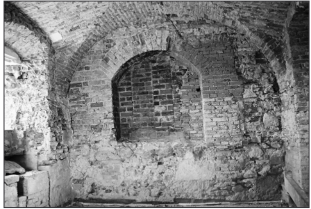
Obr. 15: Brno, Petrov 3, vyzdění pasů 1. podzemního podlaží z vysokých gotických cihel formátu II.2.
