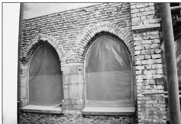
Obr. 2: Brno, dominikánský klášter, vyzdění arkád jižního křídla křížové chodby z cihel formátu I.
