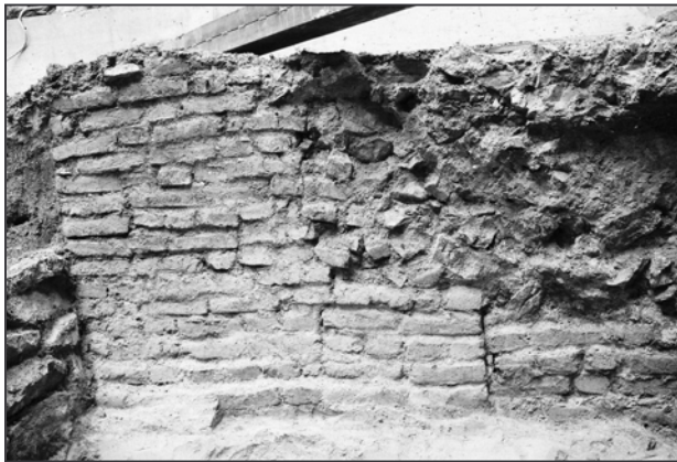
Obr. 14: Brno, Dominikánská 5, rubové zdivo vstupní šíje do 1. podzemního podlaží vyzděné z cihel formátu I.2.
