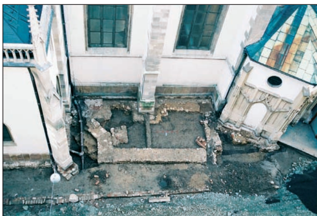
Obr. 45: Pohled od severu na odhalená zdiva kaple I (foto ArchB).
